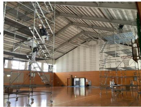
体育館の工事の様子
