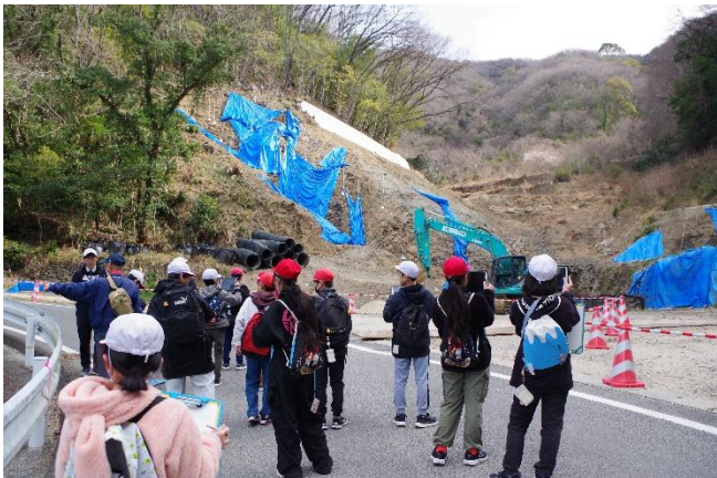
建設中の砂防ダムを見学しました
